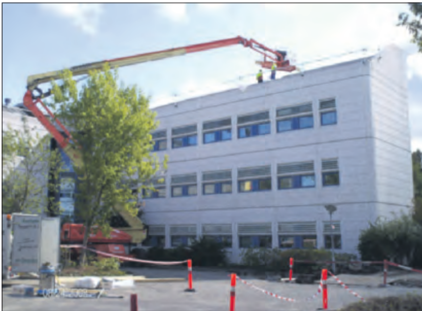
Her er firmaet i gang med at sikre en etageejendom.
